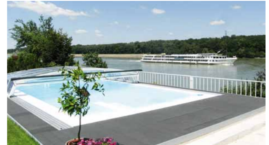
Folienbecken mit Überlaufrinne und Schwimmbadüberdachung
