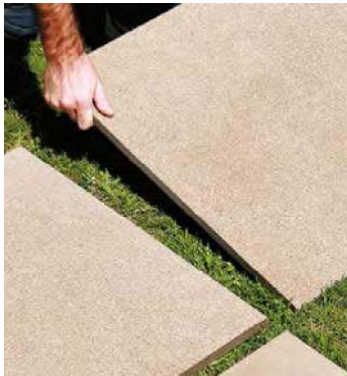
Verlegung auf Rasen
